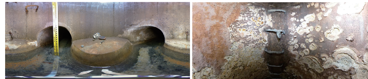
マンホール内部の点検事例、マンホールの全周について腐食、ズレ、クラックの状況を把握できます
