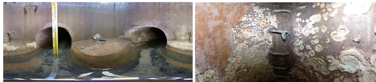
マンホール内部の点検事例、マンホールの全周について腐食、ズレ、クラックの状況を把握できます
