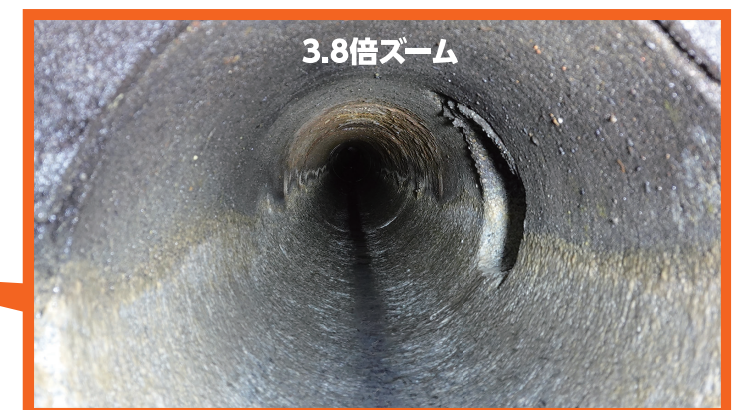
高解像度カメラの使用により、ズームして腐食、ズレ、たるみ等の異常を確認できます
