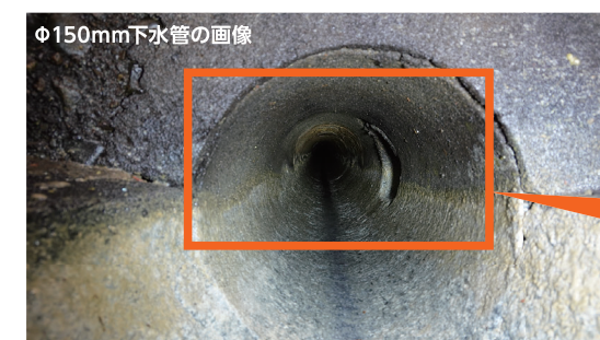
高解像度カメラの使用により、ズームして腐食、ズレ、たるみ等の異常を確認できます
